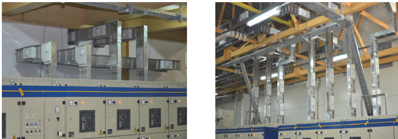
Рисунок 1 - Применение комплекта крышек угловых ШМА 5.16.37 для соединения шин секций шинопровода
