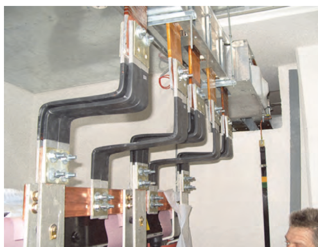
Подключение к трансформаторам
