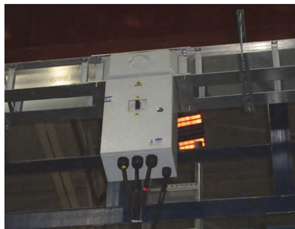
Коробка ответвительная вертикальная с автоматическим выключателем
