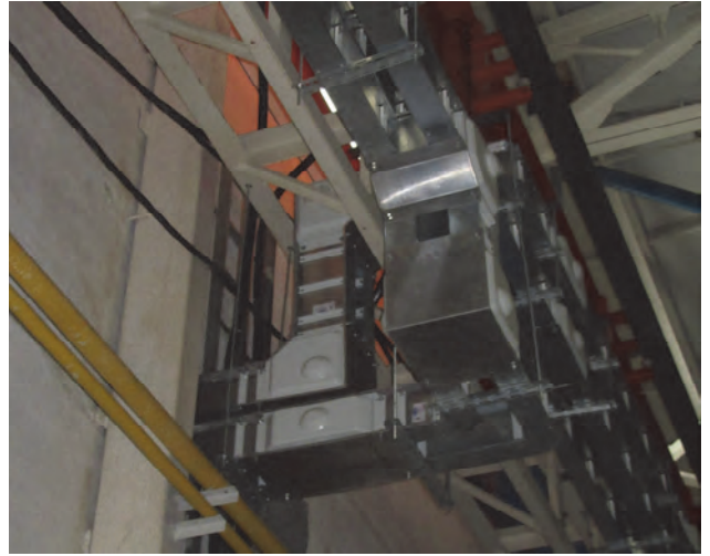
Крышка угловая – соединение любых двух секций шинпровода под углом 90°
