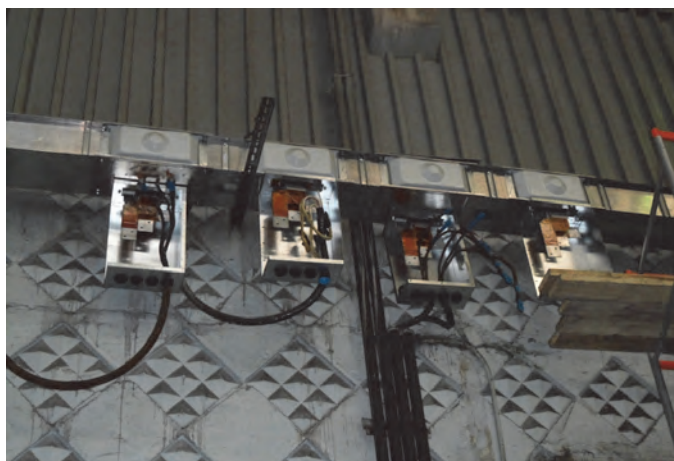
Коробка ответвительная вертикальная без автоматического выключателя
