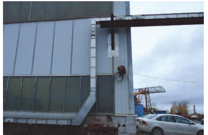
Прокладка шинпровода по улице в защитном кожухе
