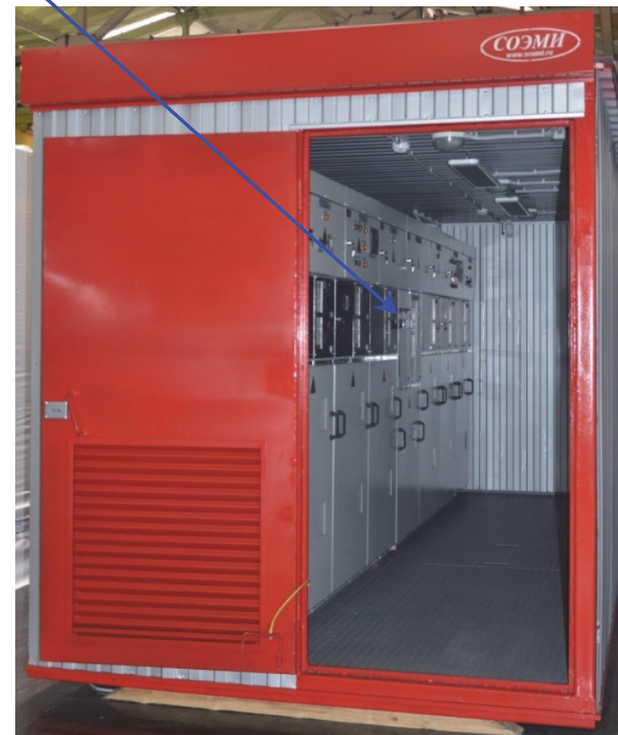
в металлических блок-модулях (наружная установка)
