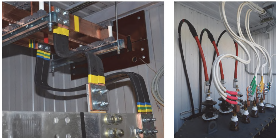
Рис. 4.2.1 Подключение силового трансформатора
