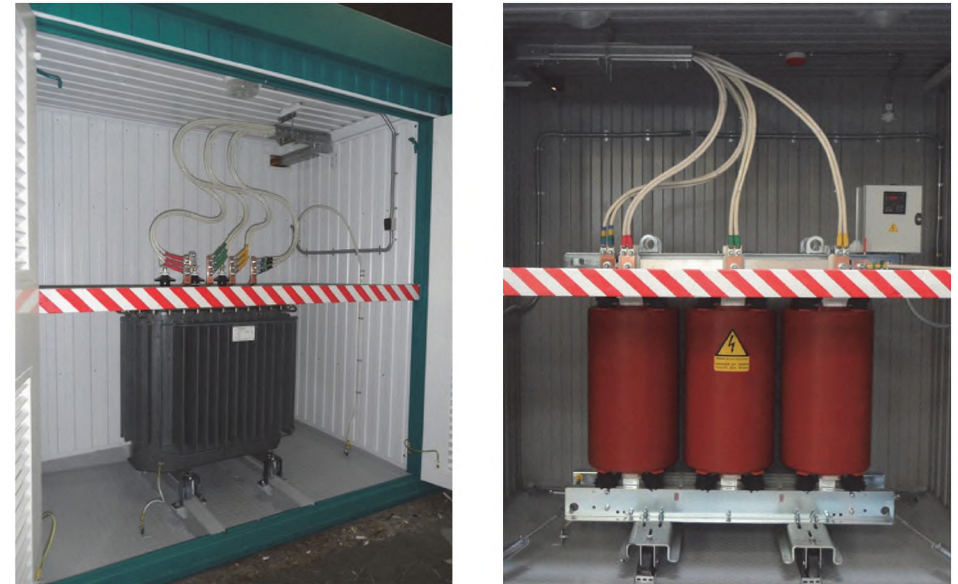
Рис. 4.2.2 Компоновка трансформаторного отсека
