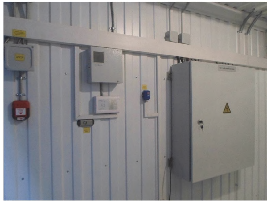
Рис. 7.1 Пример комплектации охранно-пожарной сигнализации
