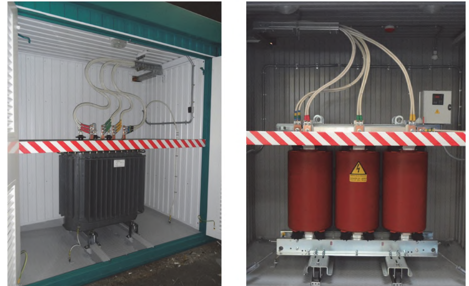
Рис. 4.2.2 Компоновка трансформаторного отсека
