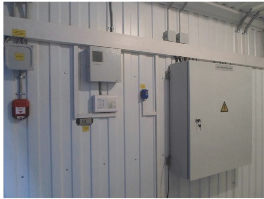
Рис. 7.1 Пример комплектации охранно-пожарной сигнализации
