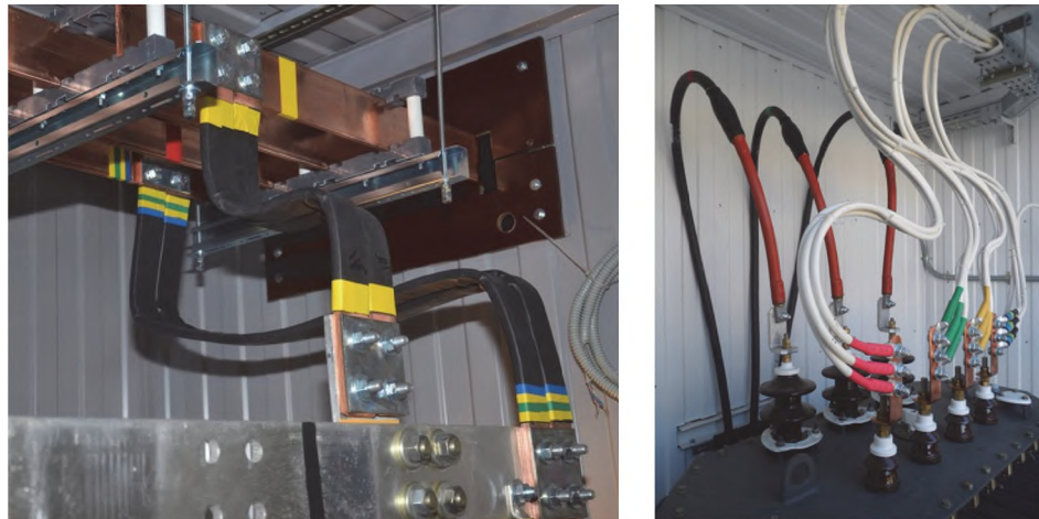
Рис. 4.2.1 Подключение силового трансформатора
