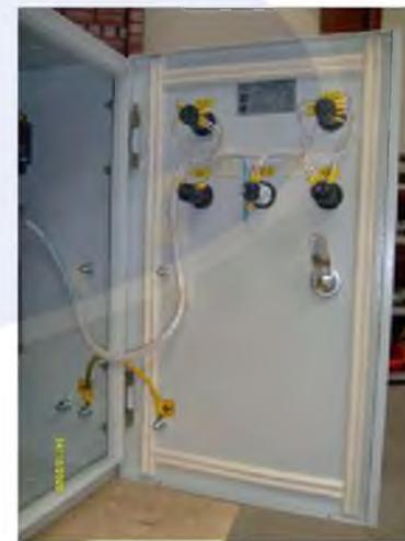
Рис. 5.2. Конструкция ящика ЯУО 9600С
